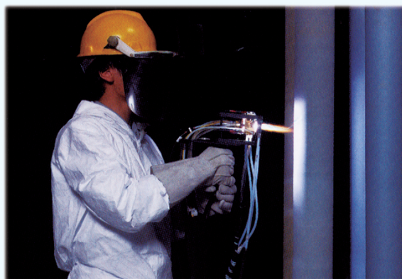
機械施行と手作業ガンによる施工を使い分けます
